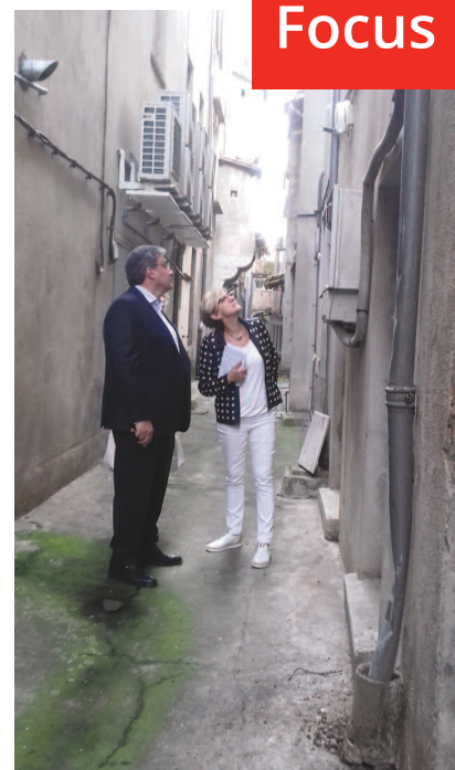
Assainie, refaite et éclairée, la venelle de Paris pourrait permettre l'accès à près de 40 logements en étage privés d'entrée.
